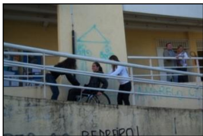
Figura 86 – Aluna na cadeira de rodas precisando de ajuda para subir a rampa
