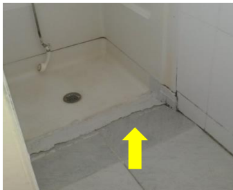
Figura 73 – Banheiros com atrás dos leitos – Produtos do Uso.
