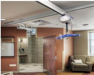
Figura 35 – Trilhos no teto facilitam o deslocamento dos pacientes.
