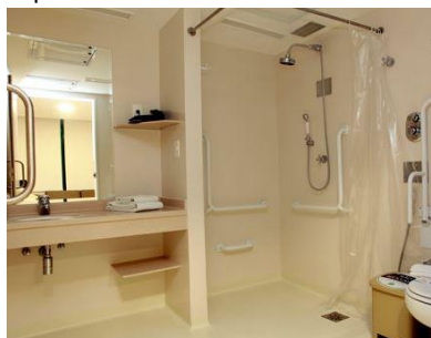
Figura 36 – Banheiro com barras e suportes facilitam as atividades.
