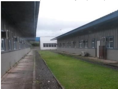
Figura 54 – Espaço livre entre os Blocos vista pela circulação principal.
