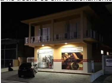
Figura 26- Mercearia no trecho 08 em funcionamento no período noturno.
