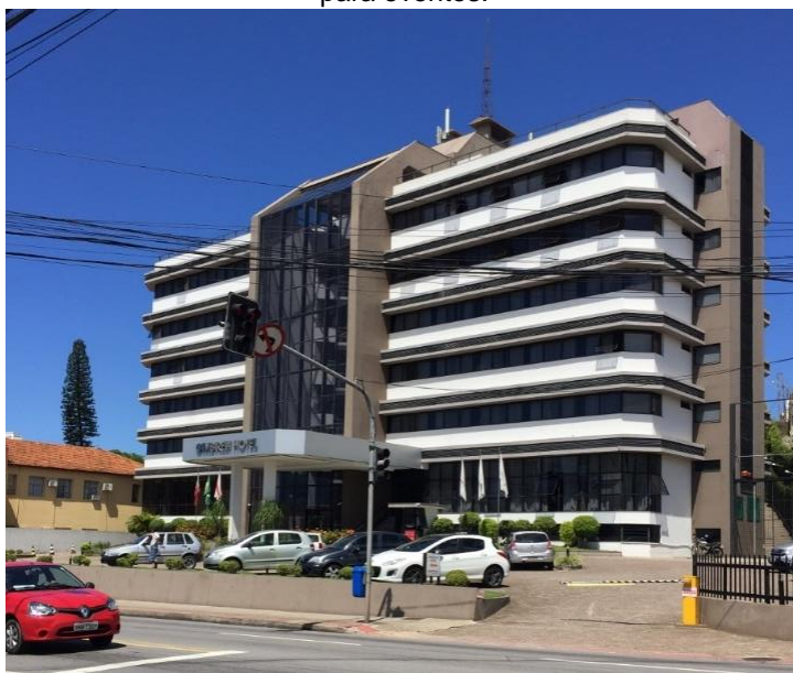
Figura 23 - Trecho 41: Hotel Cambirela com 100 acomodações e 12 salões para eventos.
