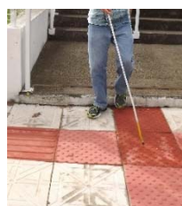
Figura 103 - Calçada – piso tátil
