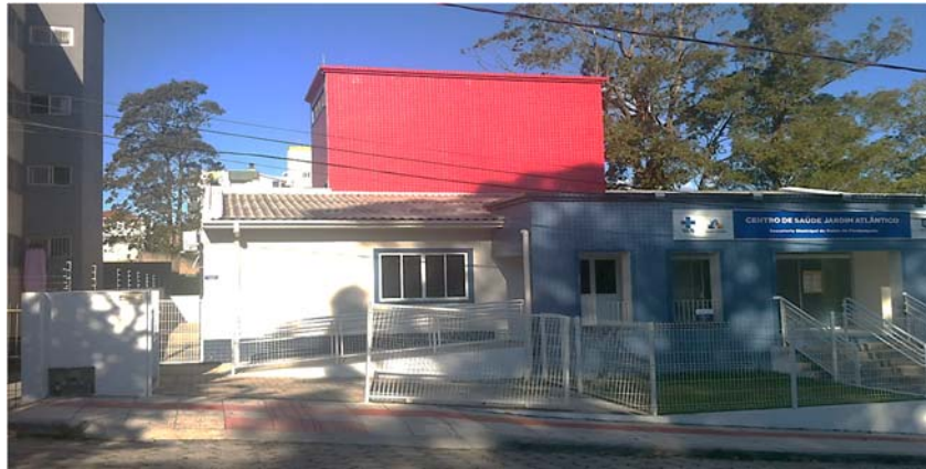
Figura 15 - Centro de Saúde - Acesso lateral e acesso principal
