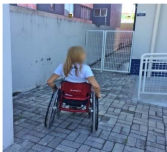
Figura 65 - Patamar da rampa
