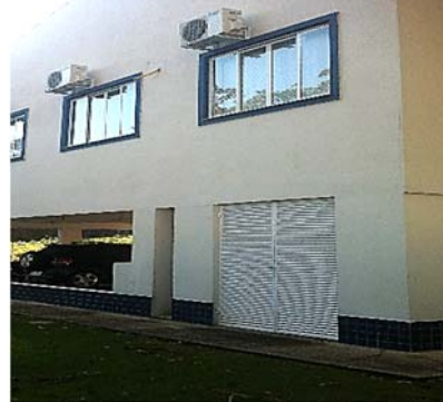
Figura 19 - Sala compressor e gramado
