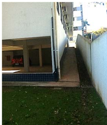
Figura 20 - início rampa fundos
