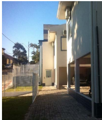
Figura 21 - Frente - mureta –Gramado
