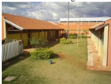
Pátio interno do Colégio
