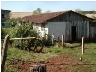
Roda d'água (fundos da cozinha da escola)
