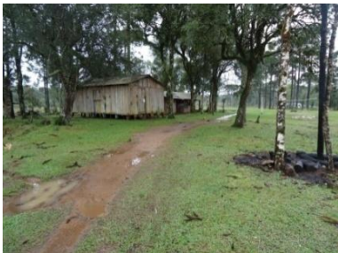
Vista da escola, construção à direita
