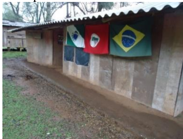
Vista parcial da escola
