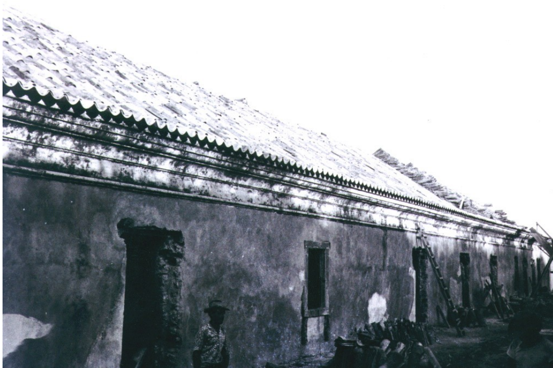
Figura 6: Vista do Quartel da Tropa da Fortaleza de Santa Cruz de Anhatomirim, durante a sua restauração, onde é possível ver o andamento dos trabalhos no telhado. Acervo do DAEx/UFSC - Data: 1974
