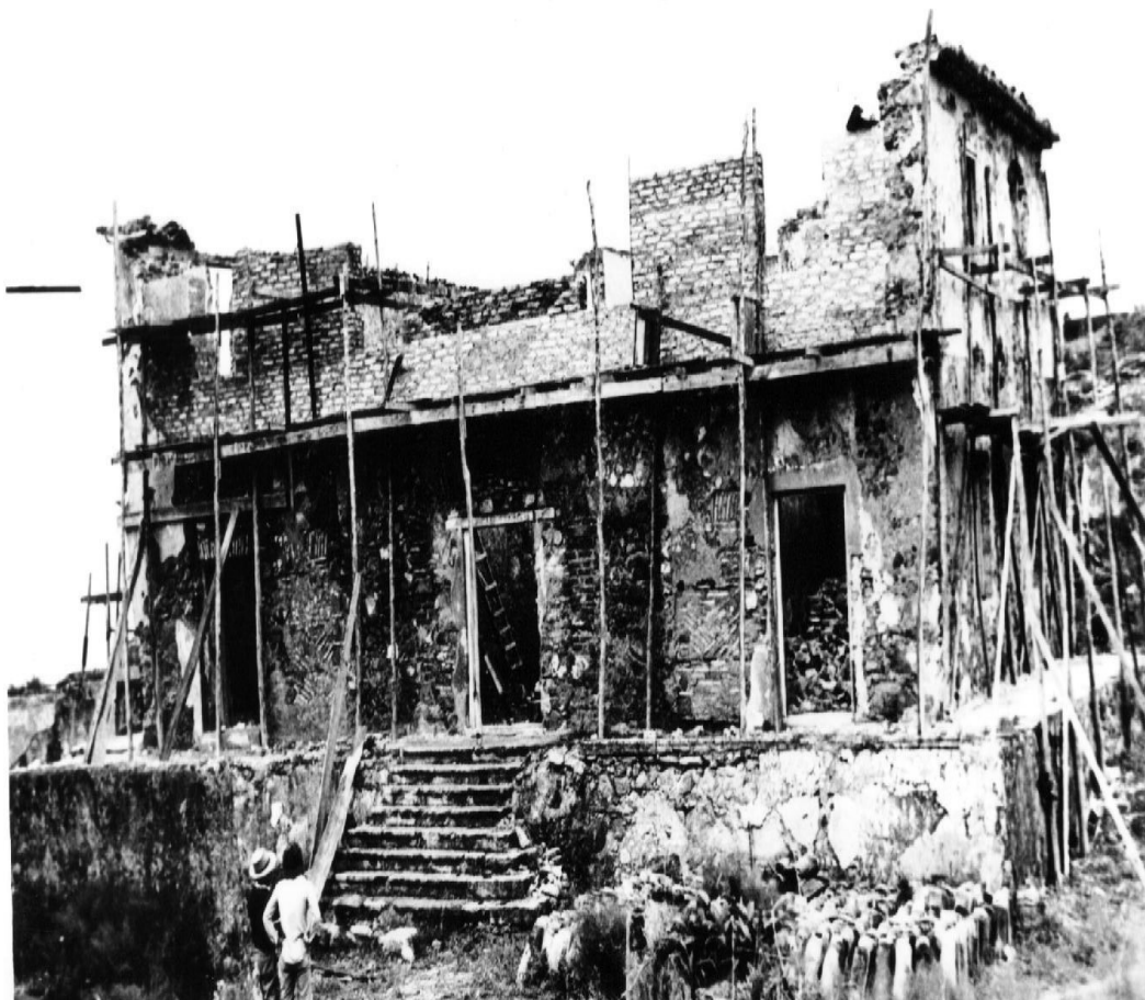
Figura 10: Obras de restauração da Casa do Comandante. Acervo Fortalezas Multimídia. Data: aprox. 1970.
