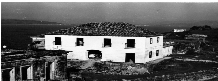
Figura 11: Sequência das obras de restauração da Casa do Comandante. Acervo Fortalezas Multimídia. Data: aprox. 1970
