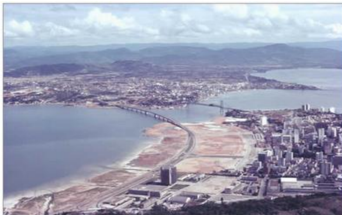
Imagem 6: Construção do aterro da Baía Sul no centro de Florianópolis em 1975
